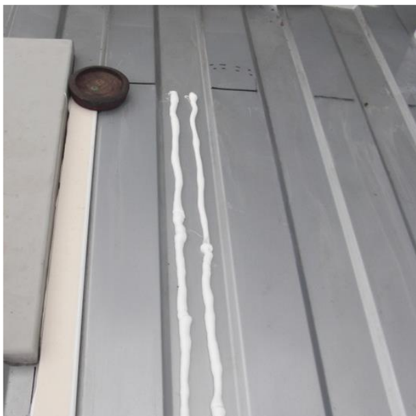
Рисунок 16. Заполнение зазоров
